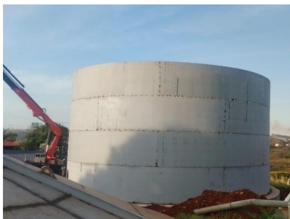
Figura 13. Conclusão da montagem da 3ª virola do costado do reservatório.
