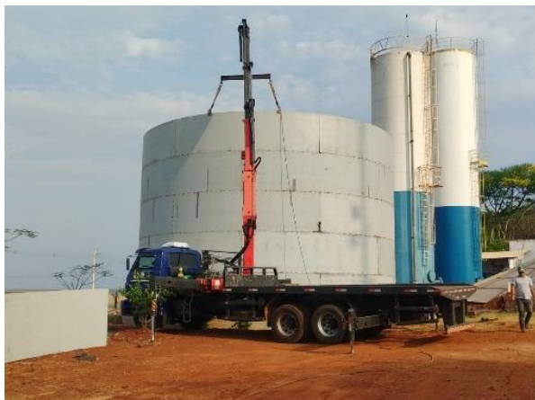
Figura 14. Conclusão da montagem da 5ª virola do costado do reservatório.
