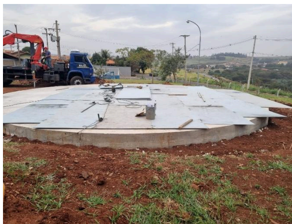
Figura 3. Vista da montagem das chapas do fundo do reservatório metálico.
