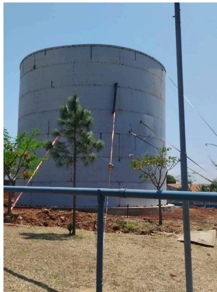
Figura 33. Vista do reservatório metálico após os reparos, com os perfis de arredondamento concluídos e fixações externas instaladas para prevenção e segurança estrutural.
