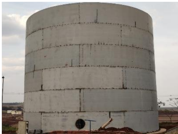
Figura 15. Conclusão da montagem da 6ª virola do costado do reservatório.
