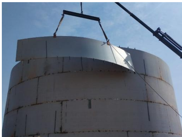
Figura 16. Vista da montagem da 7ª virola do costado do reservatório.
