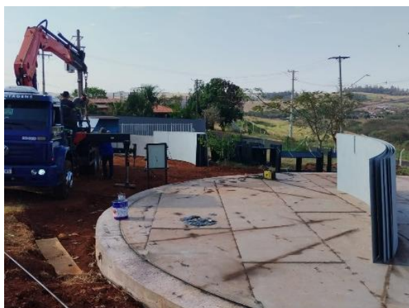
Figura 8. Início da montagem da 1ª virola do costado do reservatório.
