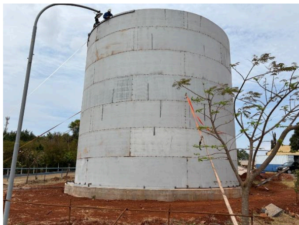
Figura 29. Vista da instalação do perfil de arredondamento do reservatório.
