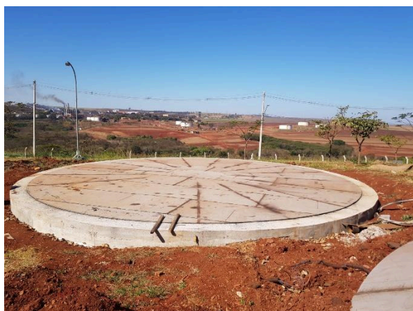
Figura 6. Vista da conclusão do fundo do reservatório metálico.
