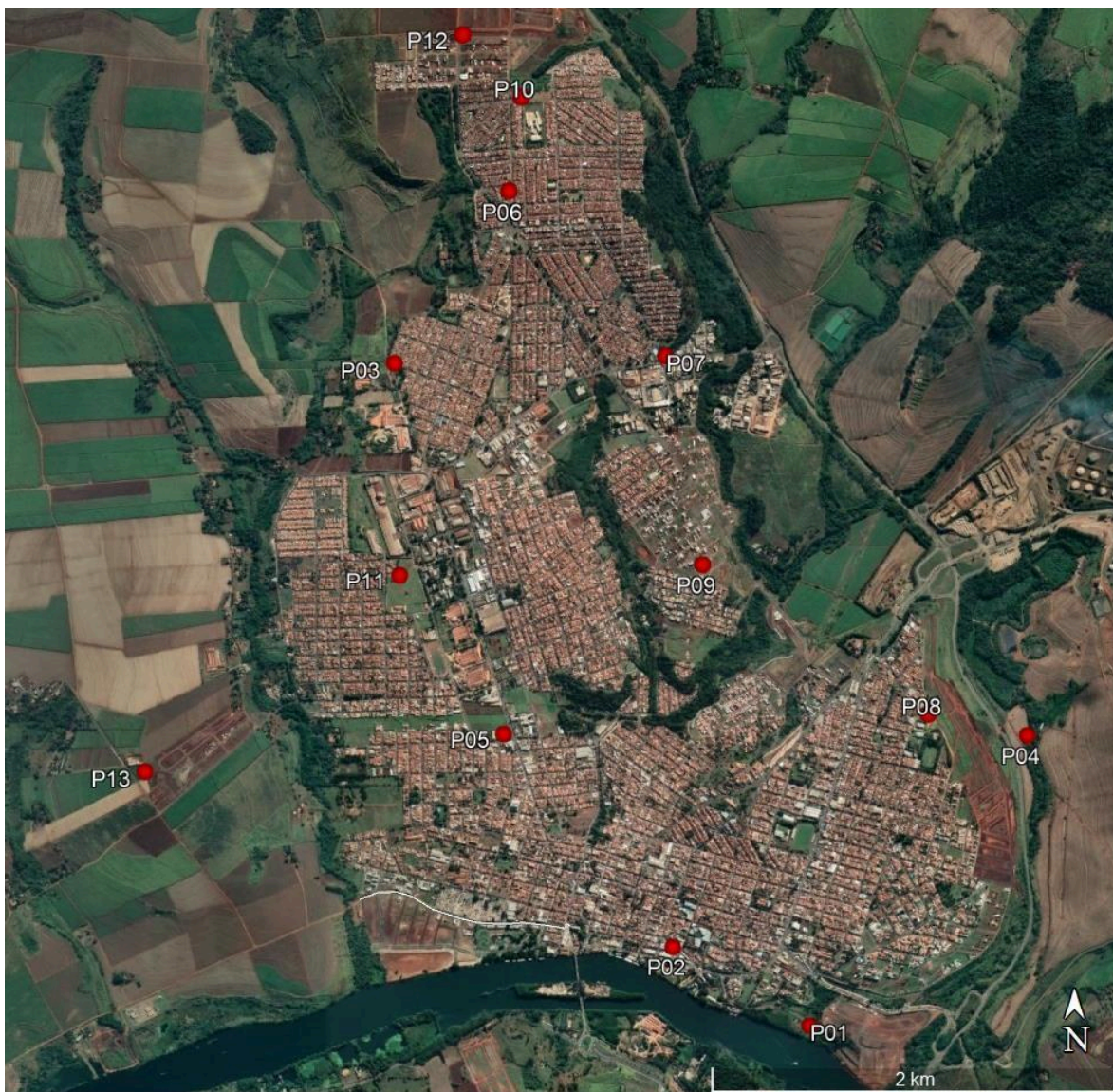
Figura 3 - Localização dos poços existentes no município de Barra Bonita
