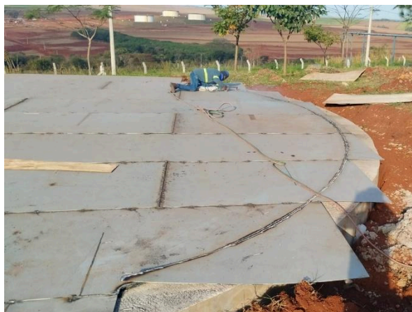
Figura 5. Vista do corte das chapas do fundo do reservatório metálico.
