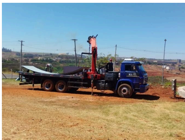
Figura 7. Vista da mobilização das chapas do costado do reservatório.
