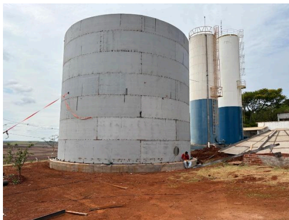
Figura 17. Conclusão da montagem da 7ª virola do costado do reservatório
