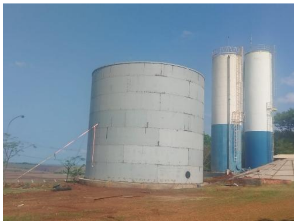
Figura 34. Vista da conclusão da instalação dos perfis de arredondamento do reservatório metálico em data de 10 de outubro do ano corrente.
