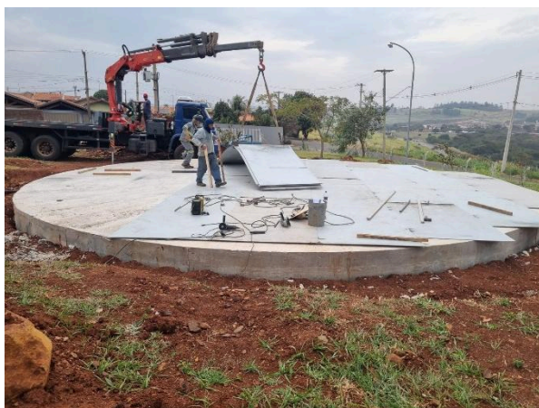
Figura 2. Vista da montagem das chapas do fundo do reservatório metálico.
