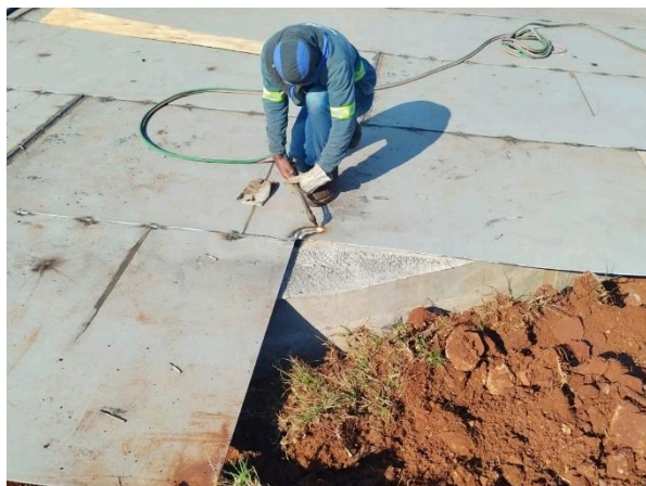
Figura 4. Vista do corte das chapas do fundo do reservatório metálico.
