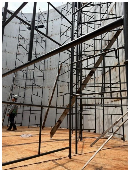
Figura 18. Vista interna do costado do reservatório metálico após a conclusão da montagem da 7ª virola do costado em data de 07 de outubro de 2025.
