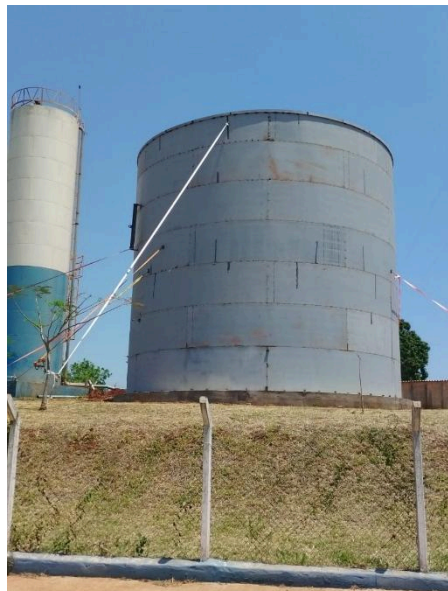
Figura 32. Vista do reservatório metálico após os reparos, com os perfis de arredondamento concluídos e fixações externas instaladas para prevenção e segurança estrutural.
