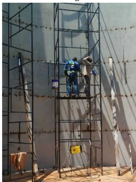
Figura 26. Vista do reforço das soldas nos cruzamentos das chapas do costado e fixação com viga I.
