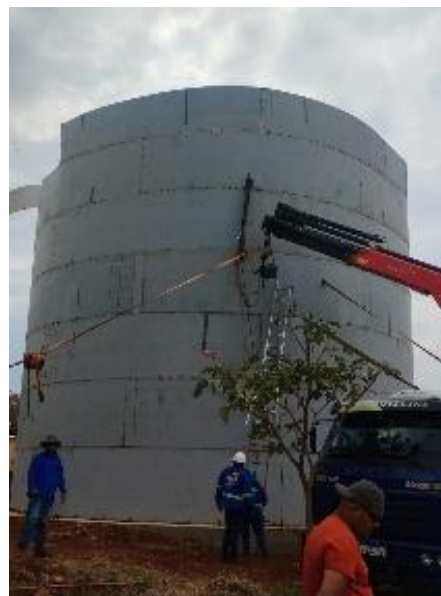
Figura 25. Vista das ações para reparo dos danos causados no costado.
