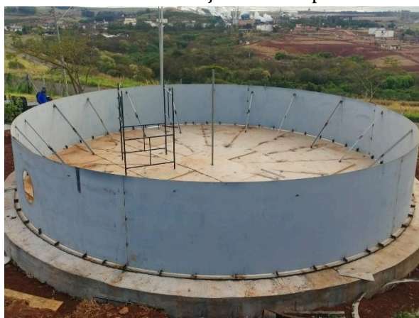
Figura 9. Vista da montagem da 1ª virola do costado e fixação das chapas.
