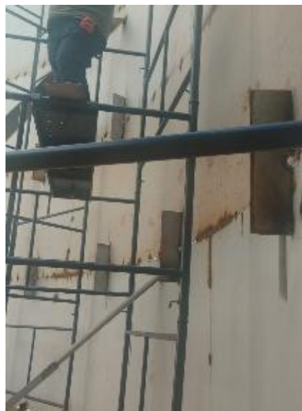
Figura 19. Vista interna do costado do reservatório (fixação das chapas e cruzamento das soldas internas).
