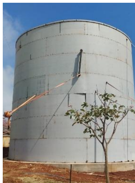
Figura 31. Conclusão da instalação do perfil de arredondamento do reservatório.
