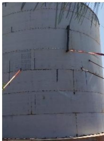
Figura 27. Vista do reparo realizado no costado e dos travamentos de fixação externo.
