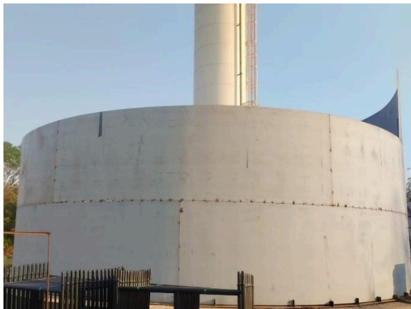
Figura 10. Vista da conclusão da montagem da 2ª virola do costado do reservatório.
