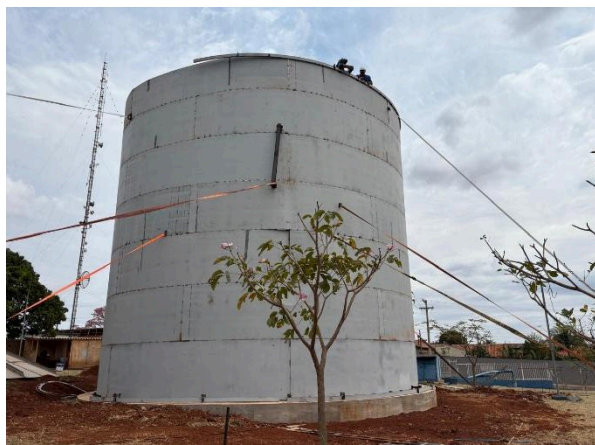
Figura 28. Vista da instalação do perfil de arredondamento do reservatório.
