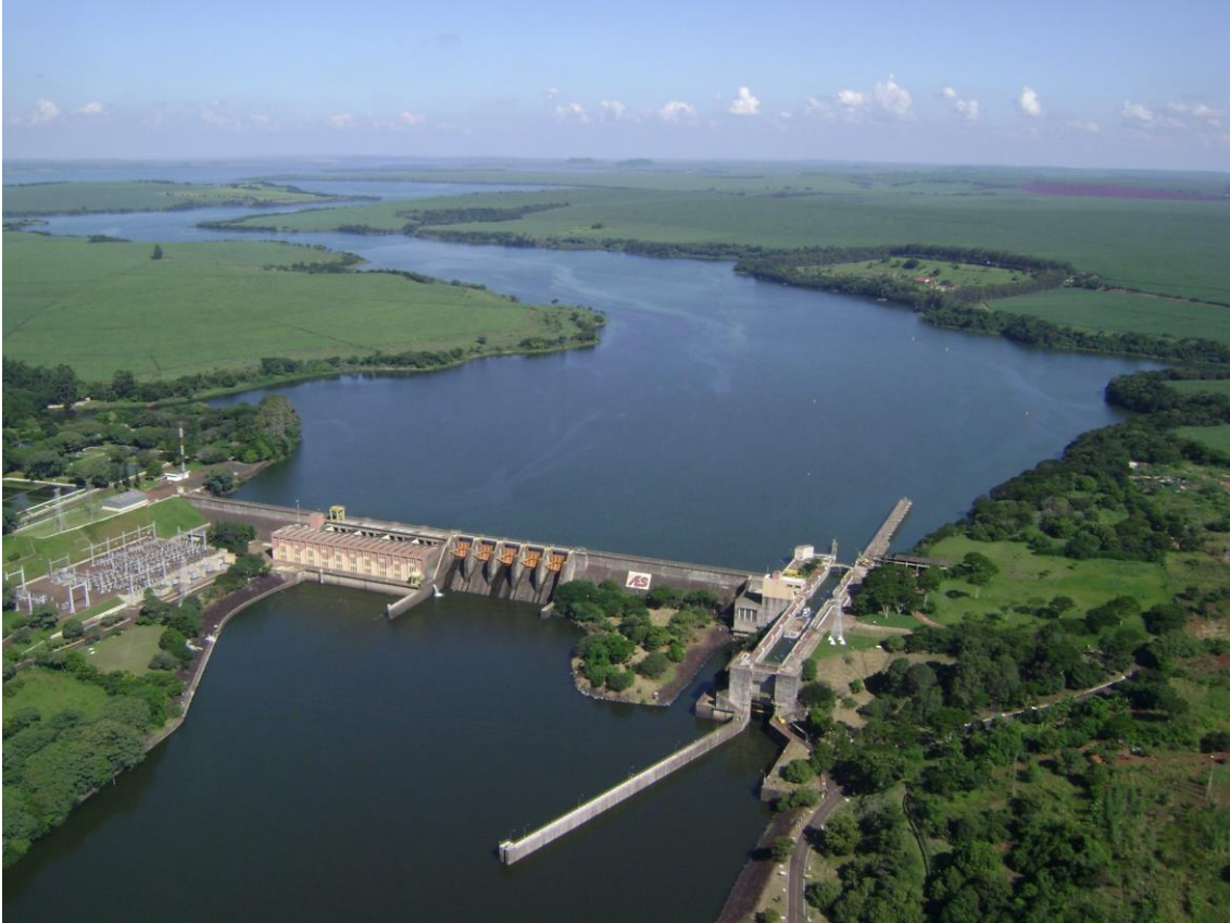
Montante e jusante da Represa de Barra Bonita
