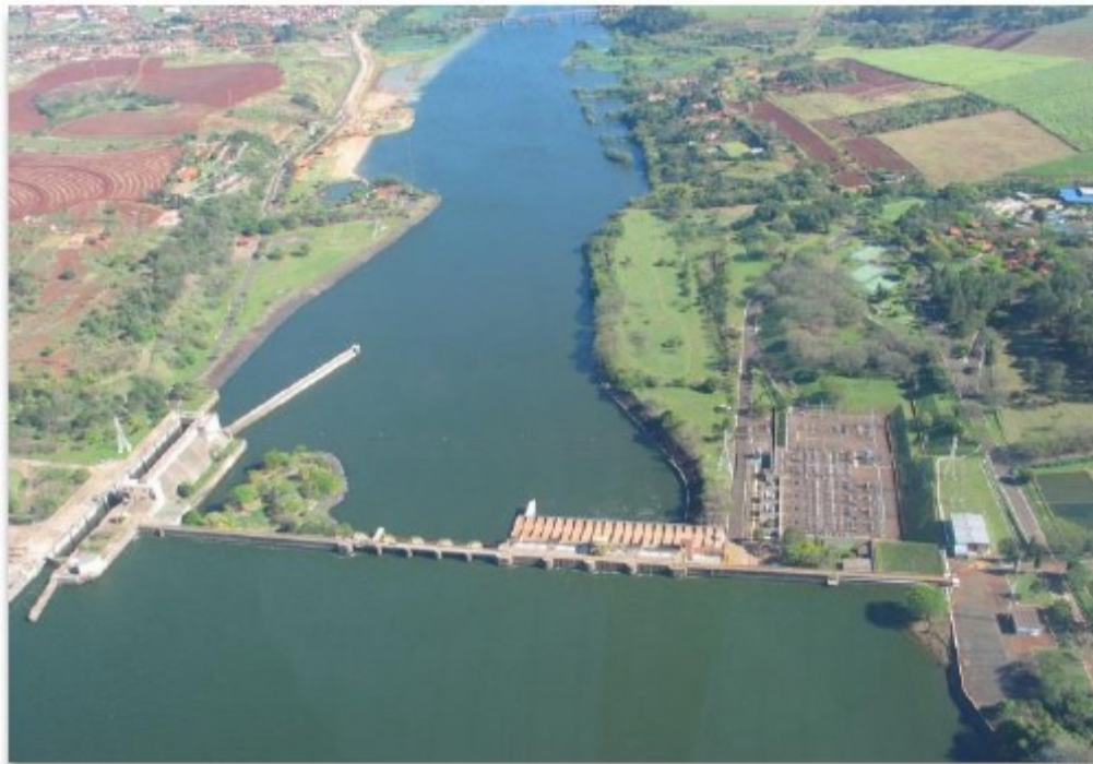
Montante e jusante da Represa de Barra Bonita
